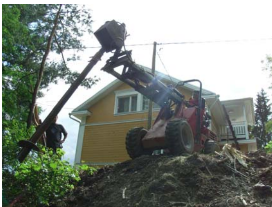
Asennus pyöräalustaisella työkoneella
