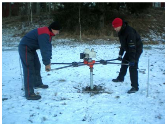
Asennus polttomoottorikäyttöisellä maaporalla
