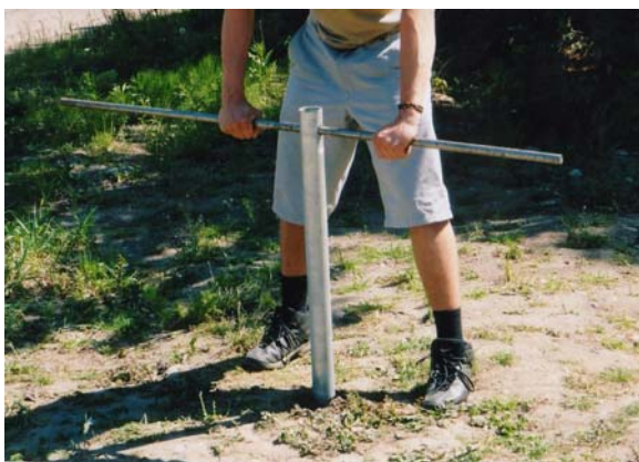
Ruuvipaalun käsinasennus rautakangella
